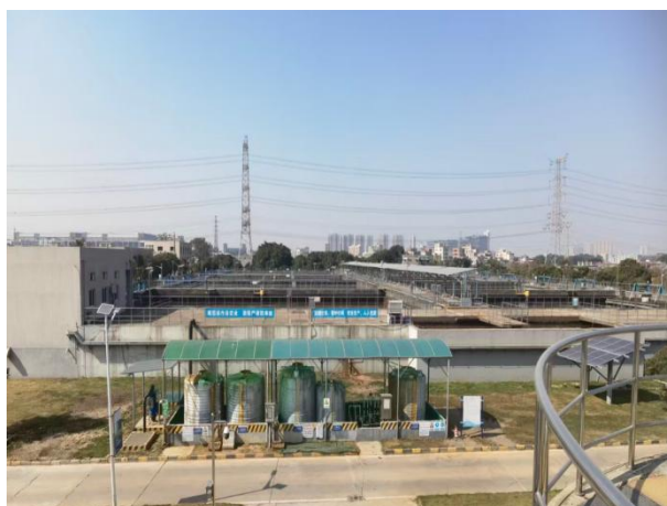
一期现状生化池图
