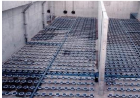
曝气器示意图安装形式示意图
