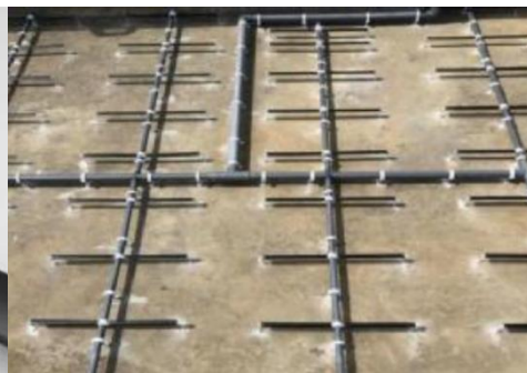
曝气器示意图安装示意图
