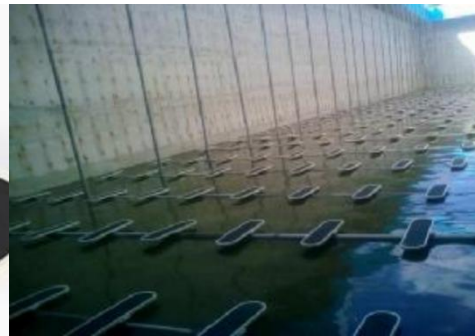
曝气器示意图安装形式示意图
