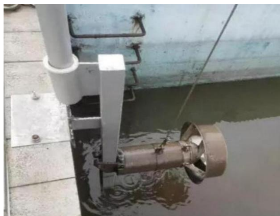
潜水搅拌器安装示意图
