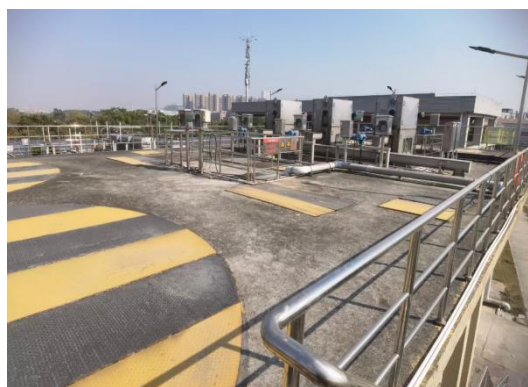
二期现状粗格栅及提升泵房图二期现状细格栅及旋流沉砂池图
