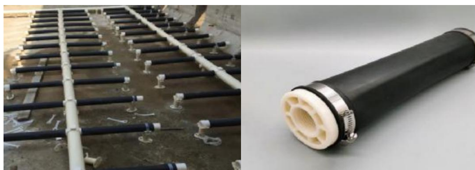
曝气器示意图安装形式示意图
