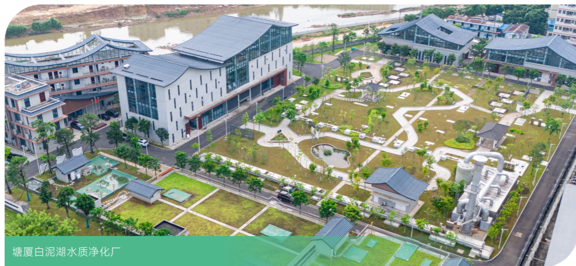
清溪厦坭水质净化厂
