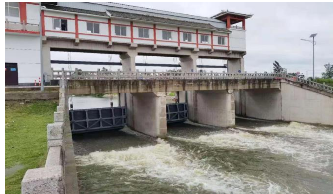
图 6.4-4 直升式平面钢闸门效果图
