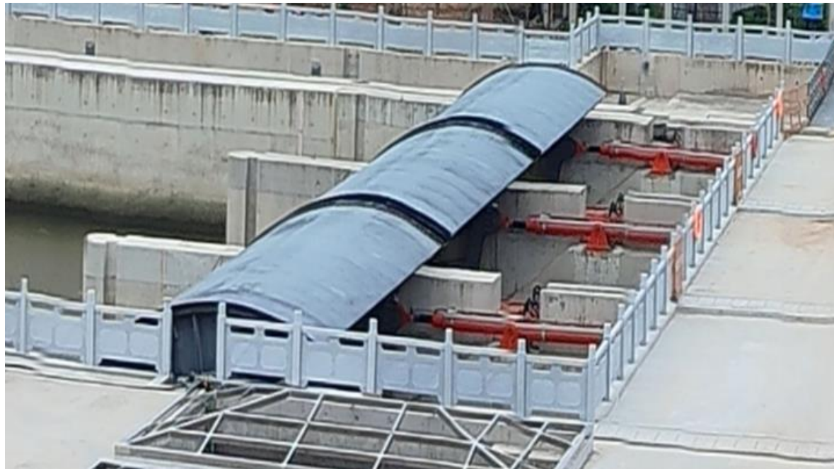
图 6.4-5 上翻式弧形钢闸门效果图
