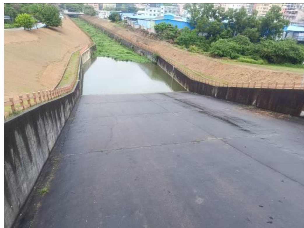
图 2.1-5 虾公岩水库溢洪道
