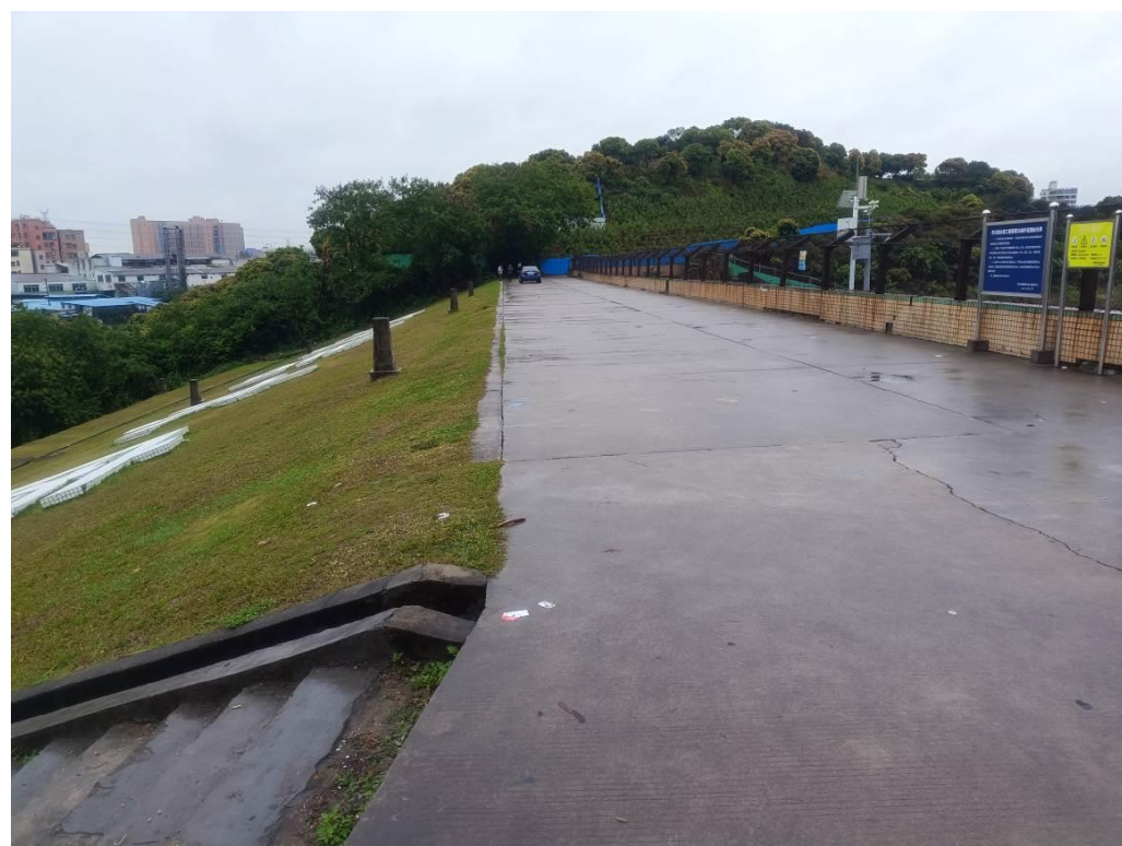
图 2.1-4 虾公岩水库大坝
